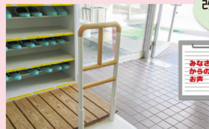
入口に手すりを設置
