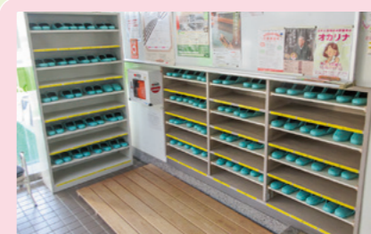
下駄箱の改修
