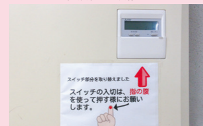
エアコン(ホール)スイッチの交換
