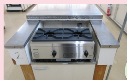
火力強ガスコンロの設置
